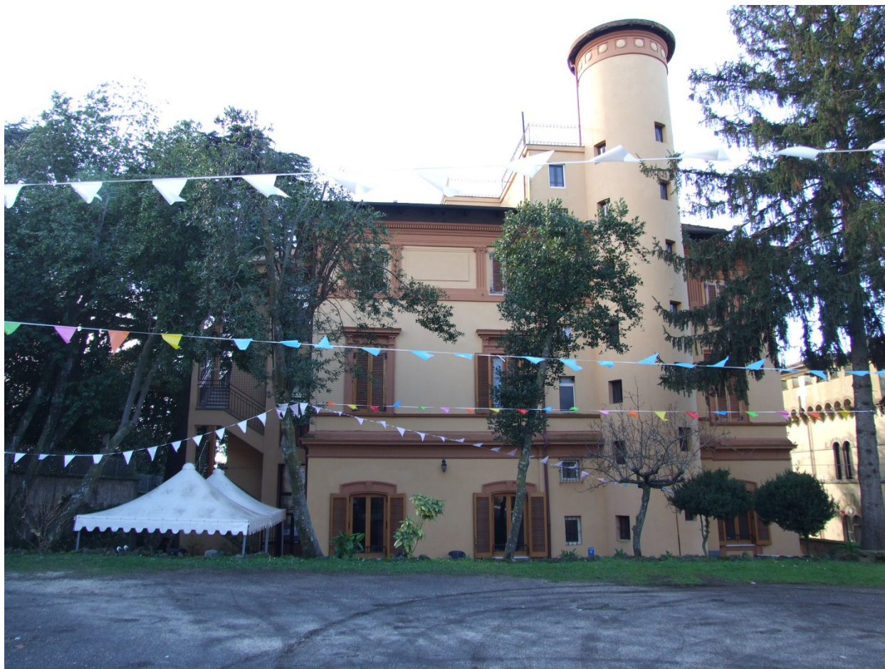
Struttura casa di riposo "S. Paolo Apostolo"
